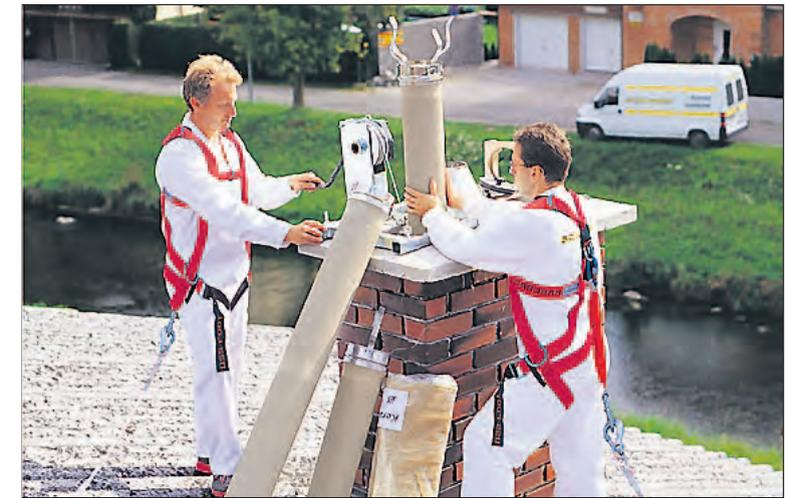
Der Einbau der neuen Abgasführung erfolgt übers Dach und ist innerhalb eines Tages abgeschlossen.
